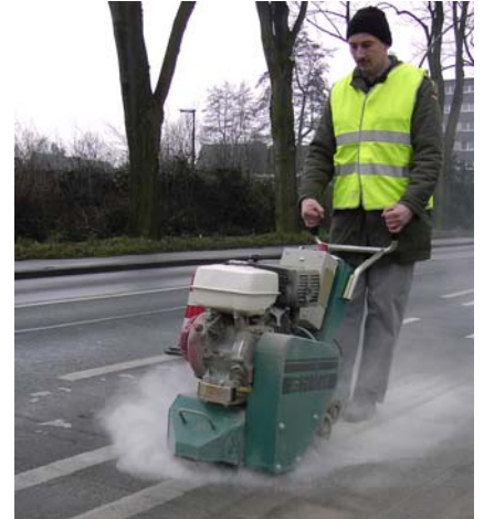
LineEx 20 – с алмазным инструментом в работе
