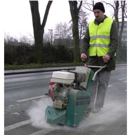
LineEx 20 – с алмазным инструментом в работе
