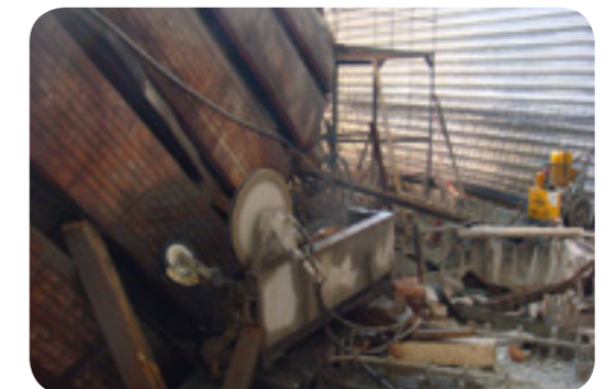
Саяно-Шушенская ГЭС Канатная техника CEDIMA CSA-1001 H
