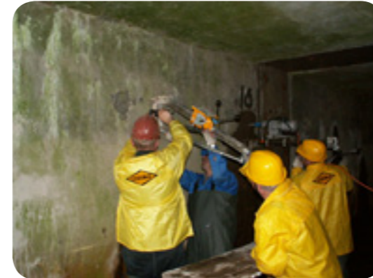
Красноярск. Реконструкция дамбы Сверильная система CEDIMA P-3000
