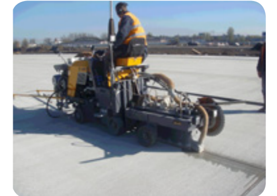
Львов. Взлетно-посадочная полоса Нарезчик швов CEDIMA CF-6020 с приспособлением «Продольная резка»
