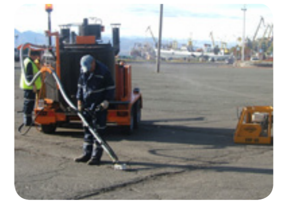
Петропавловск-Камчатский. Ремонт асфальтового покрытия Котел-заливщик Grün RVK-650 iS
