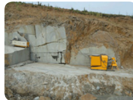
Нижне - Бурейская ГЭС Канатная техника CEDIMA CSA-1001H, CSA-2037 HF
