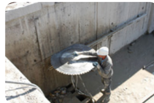
Иркутск. Демонтаж монолитного жилого дома Стенорезная машина CEDIMA WS-451 H
